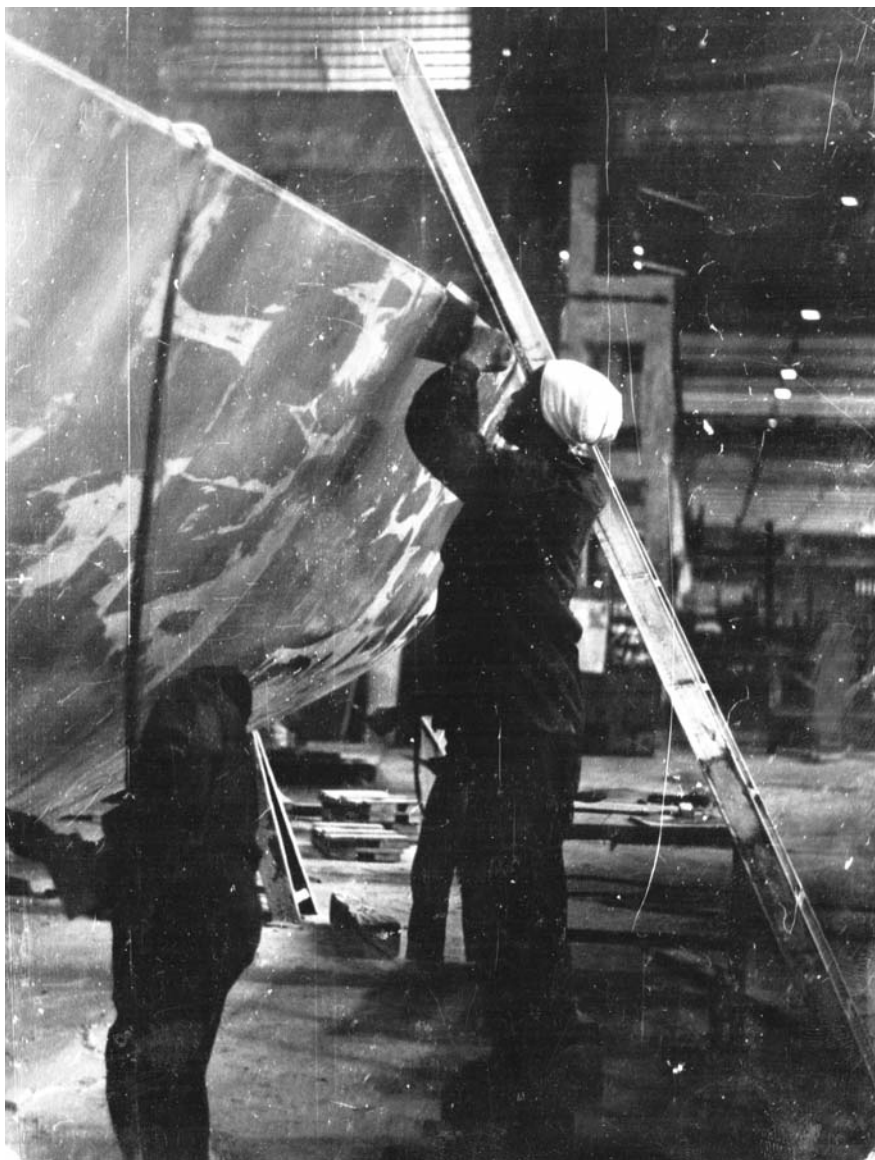
Вот так выглядел процесс шпаклевания корпуса в Потти.
