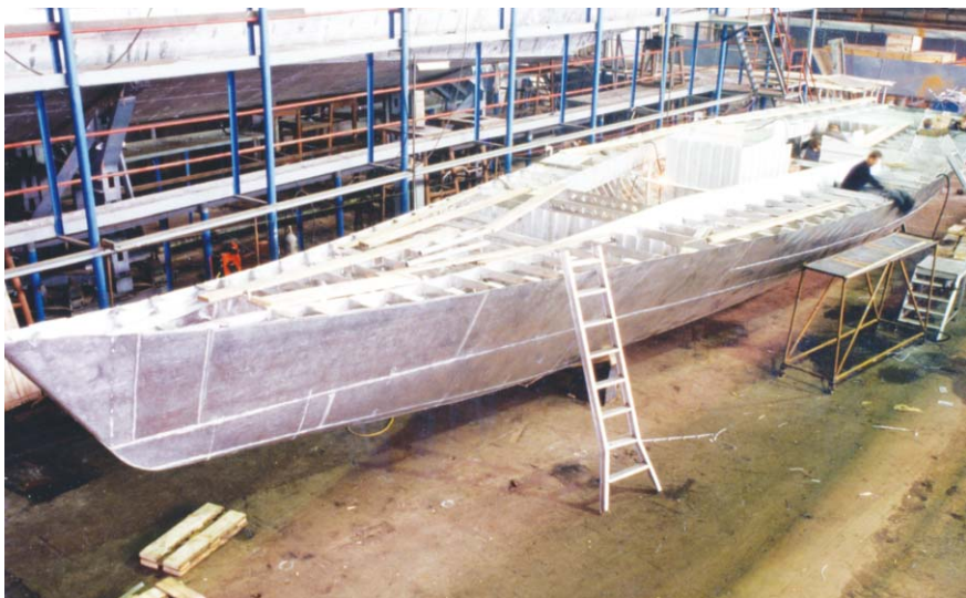
Готовимся к укладке палубы.
