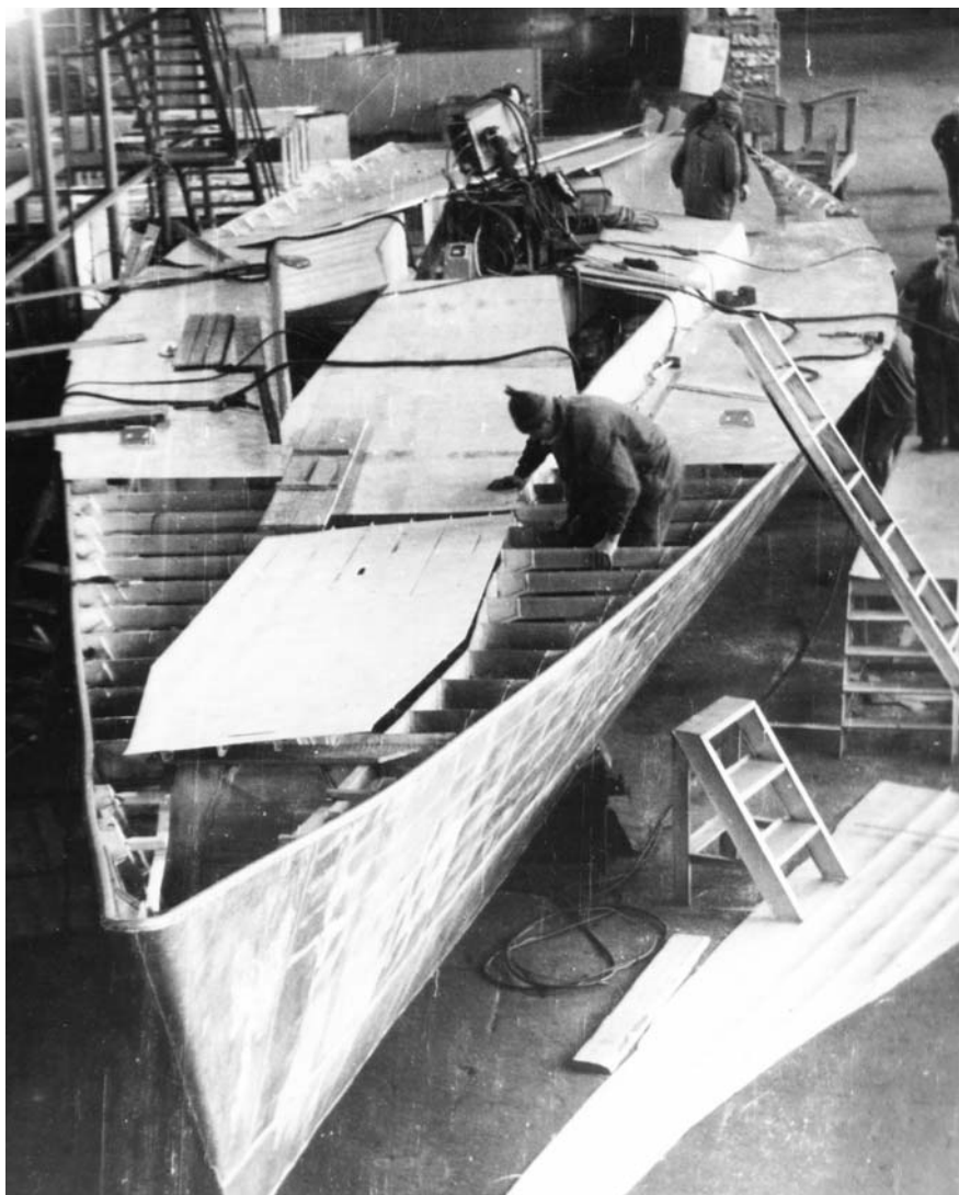
Алексей инспектирует что-то на палубе. На полу лежит очередная палубная панель готовая к установке. На носовой переборке виден путенс треугольной формы, сваренный в переборку.
