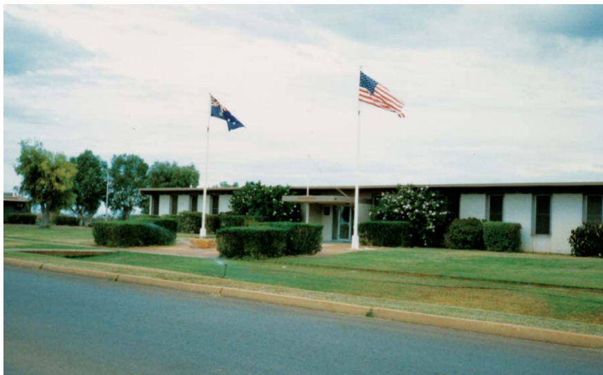
Контрольно-пропускной пункт базы.
