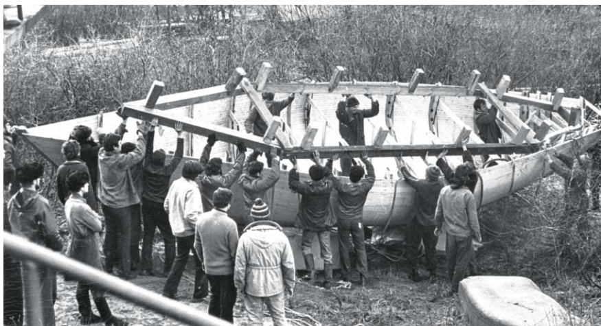
23 Ноября 1979 года. Корпус вынесен из мастерской и перевёрнут. Весь состав яхт-клуба принял участие в этом событии! Отсоединяем станпель, перед тем как занести корпус лодки обратно в мастерскую. Теперь на повестке дня – установка гнутого набора и подготовка к сборке палубы!
