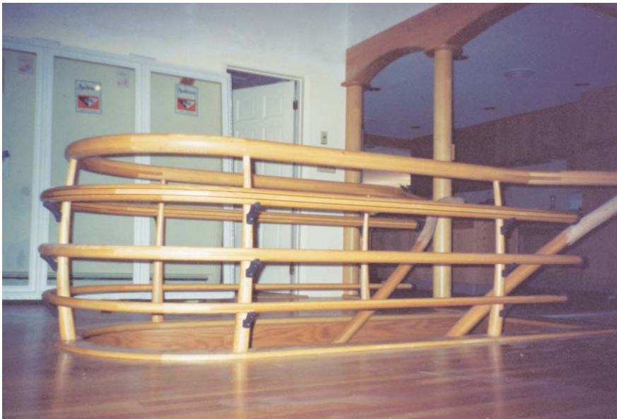
Верхний поручень – 76 мм диаметром. Поручень непрерывный – начинается с первого этажа, поднимается на второй и снова возвращается на первый этаж. Материал всей конструкции – дуб.
